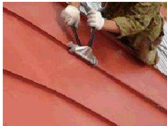
Рис.2. Фальцевая кровля
